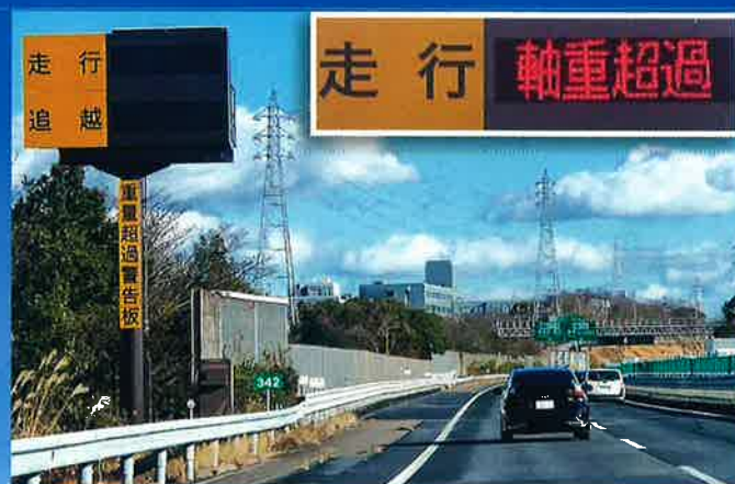
高速道路本線での「軸重超過」表示
